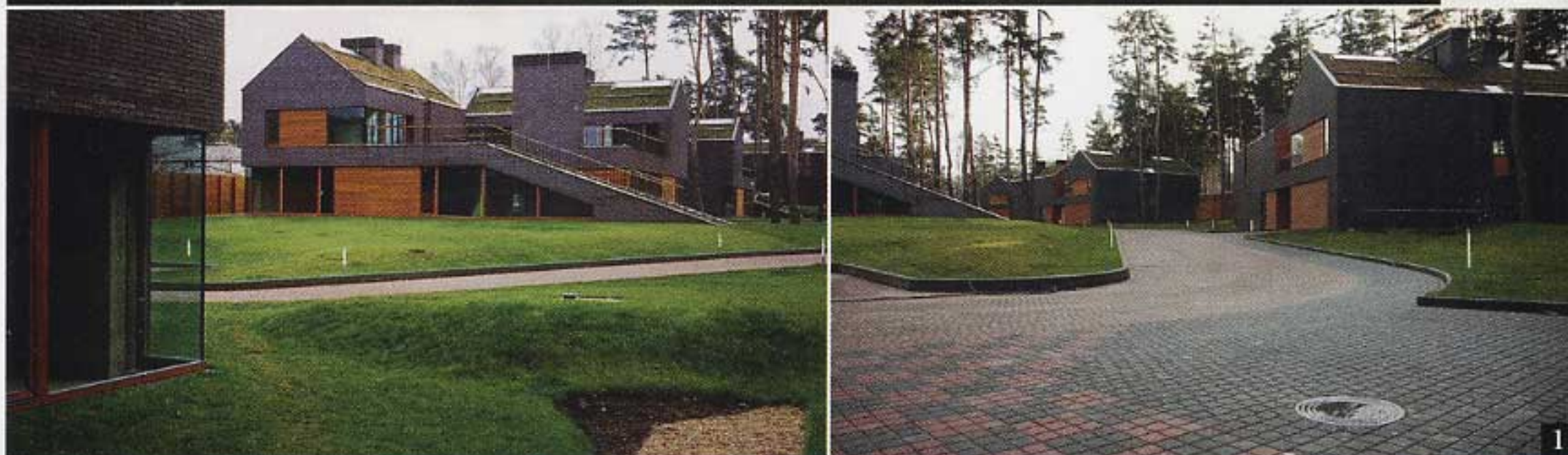
Первые этажи обшиты кедром, вторые выложены немецким кирпичом. Над гаражом неглубокий декоративный бассейн. На него выходит ванная при спальне.
